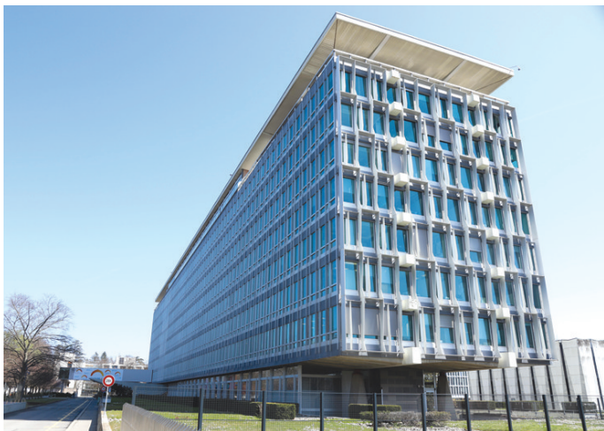
▲这是3月30日在瑞士日内瓦拍摄的世界卫生组织总部办公大楼
