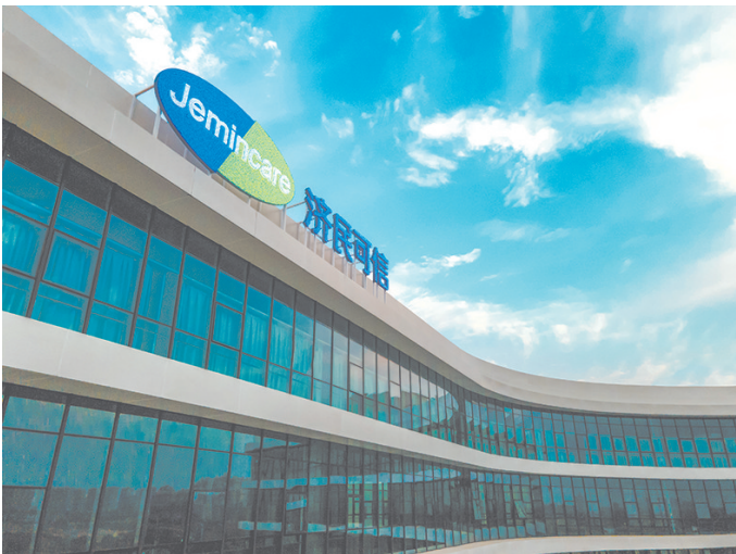
总部大楼一景。
