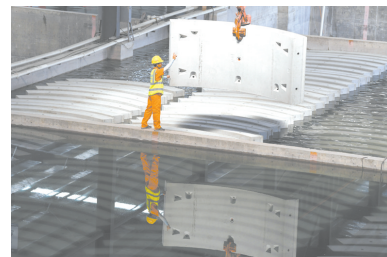
8月9日,工人在中铁四局安徽智能制造有限公司盾构管片制造基地忙碌。
