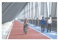
9月28日,由中国中铁大桥局承建的沪杭甬高速改建工程新彭埠大桥 正式通车。新彭埠大桥连接杭州钱塘 江南北两岸,上层为双向八车道高架 快速路,下层为双线轻轨,是国内首座 多跨长联公轨两用钢桁梁桥。
