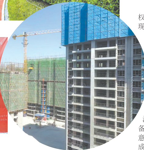
▲上饶碧桂园黄金时代工地现场
