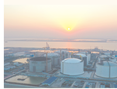
图为2022年10月19日拍摄的建设中的中石化天津液化天然气(LNG)接收站(无人机照片)。
