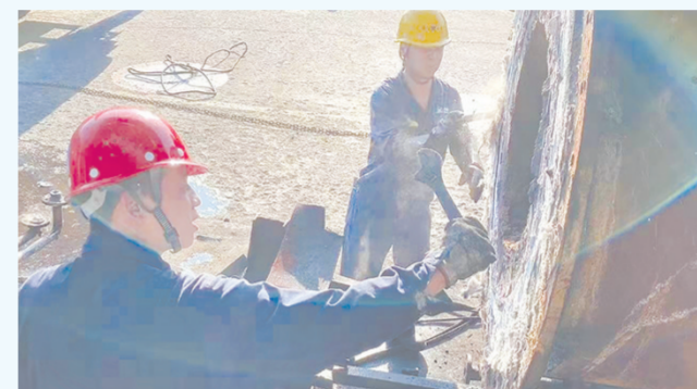
黑猫股份一线维修小组顶着炉膛散发的高温组装新的炉节。
