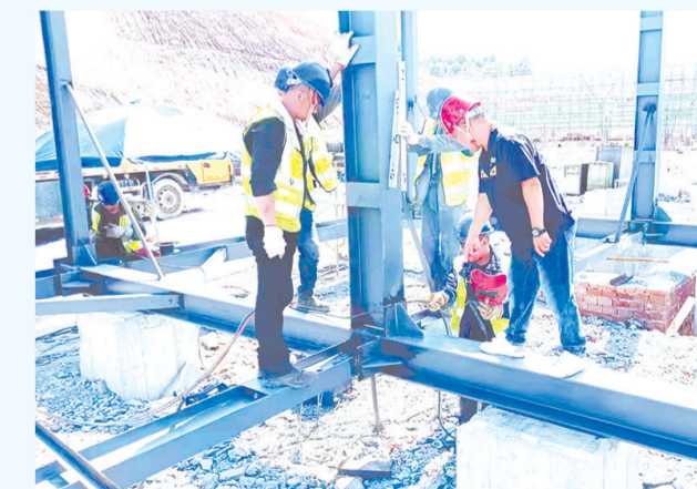
景德镇市危险废物综合处置中心项目施工现场建设现场。
