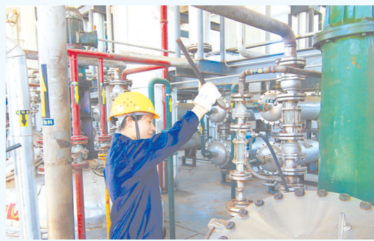
江西跃华公司员工冒着高温一丝不苟地检查设备。
